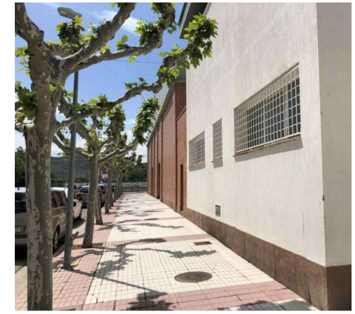
VISTA 11 Demolición de antepecho en fachada lateral 02
