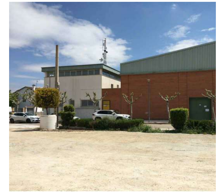
VISTA 10 Demolición de antepecho en fachada lateral
