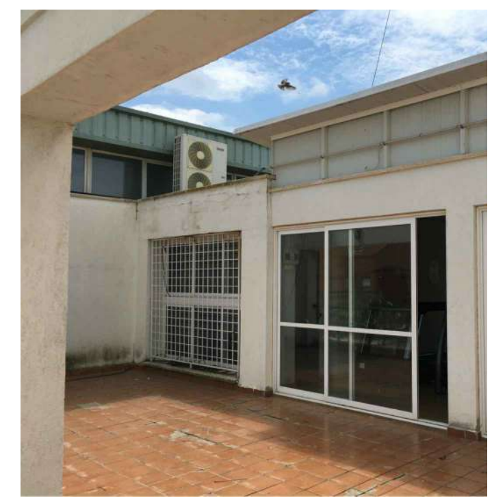
VISTA 09 Ubicación de caja de ascensor terraza 05
